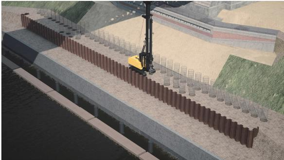
Bild 2: Visualisierung der Arbeiten am unteren südlichen Betriebsweg mit Fendern zum Schutz gegen Schiffshavarien (WNA NOK)
