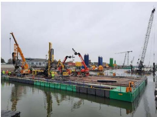
**Bildunterschrift:** Herstellung von Auftriebspfählen zur Rückverankerung der Kammersohle auf der Baustelle für die 5. Schleusenammer in Brunsbüttel.
