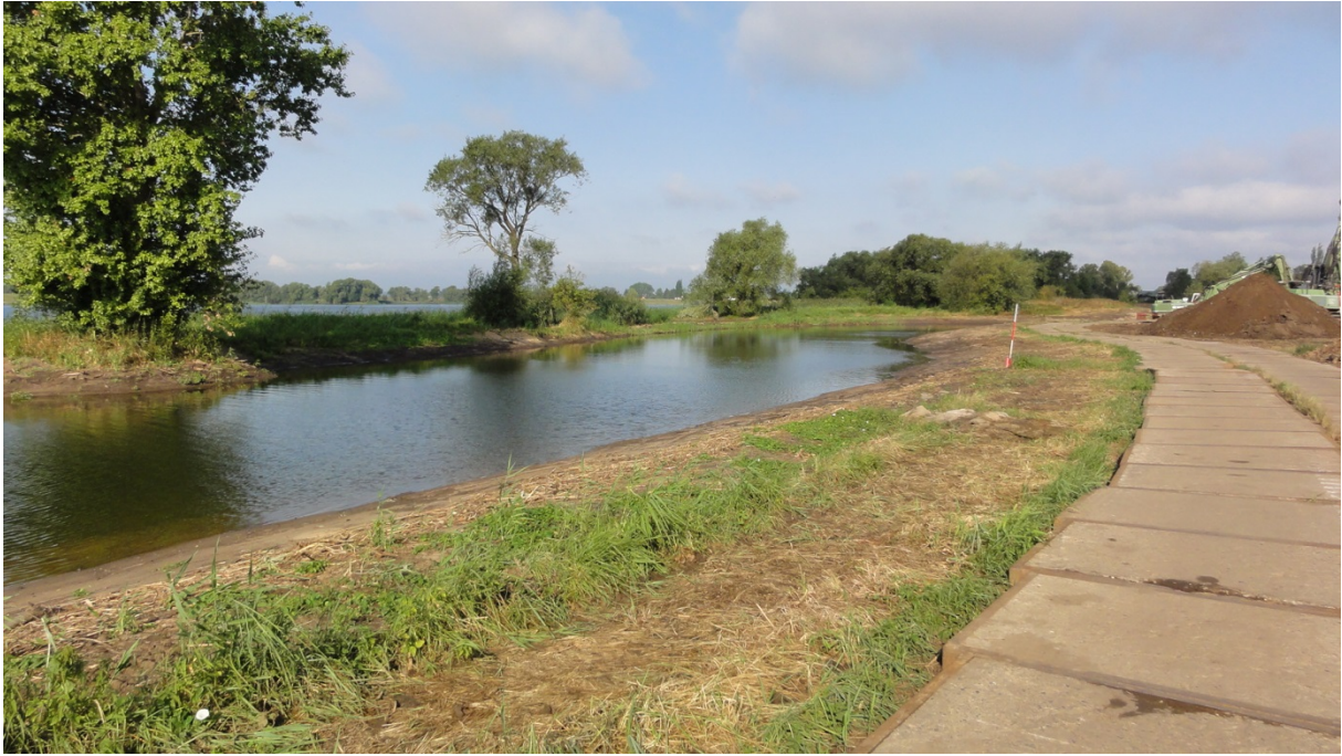
Abb. 3-4: Fertiggestellter Priel bei auflaufendem Wasser
