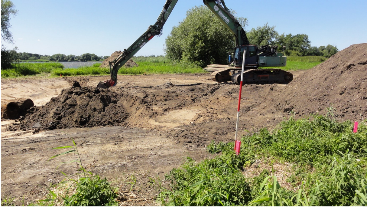
Abb. 3-2: Langarmbagger bei der Profilierung des Priels
