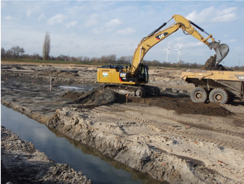
Abb. 2-5: Trennscharfer Bodenaushub
