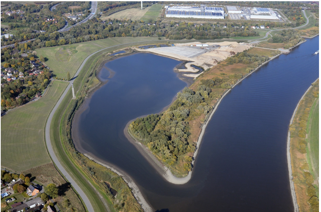
Abb. 2-6: Ausbauzustand Oktober 2018 (Blick von Süden)
