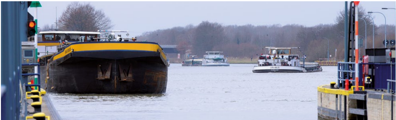
Mittellandkanal Schleuse Sülfeld
