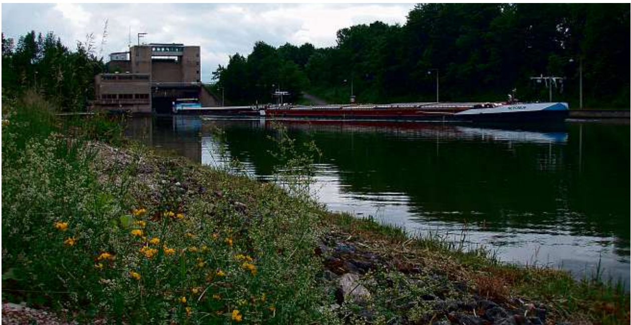
Die bestehende Schleuse Kriegenbrunn
