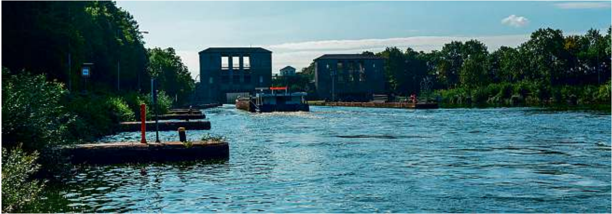
Unterer Vorhafen der Schleuse Üfingen
