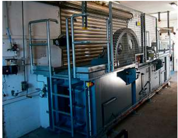
Windwerk nach Grundinstandsetzung
