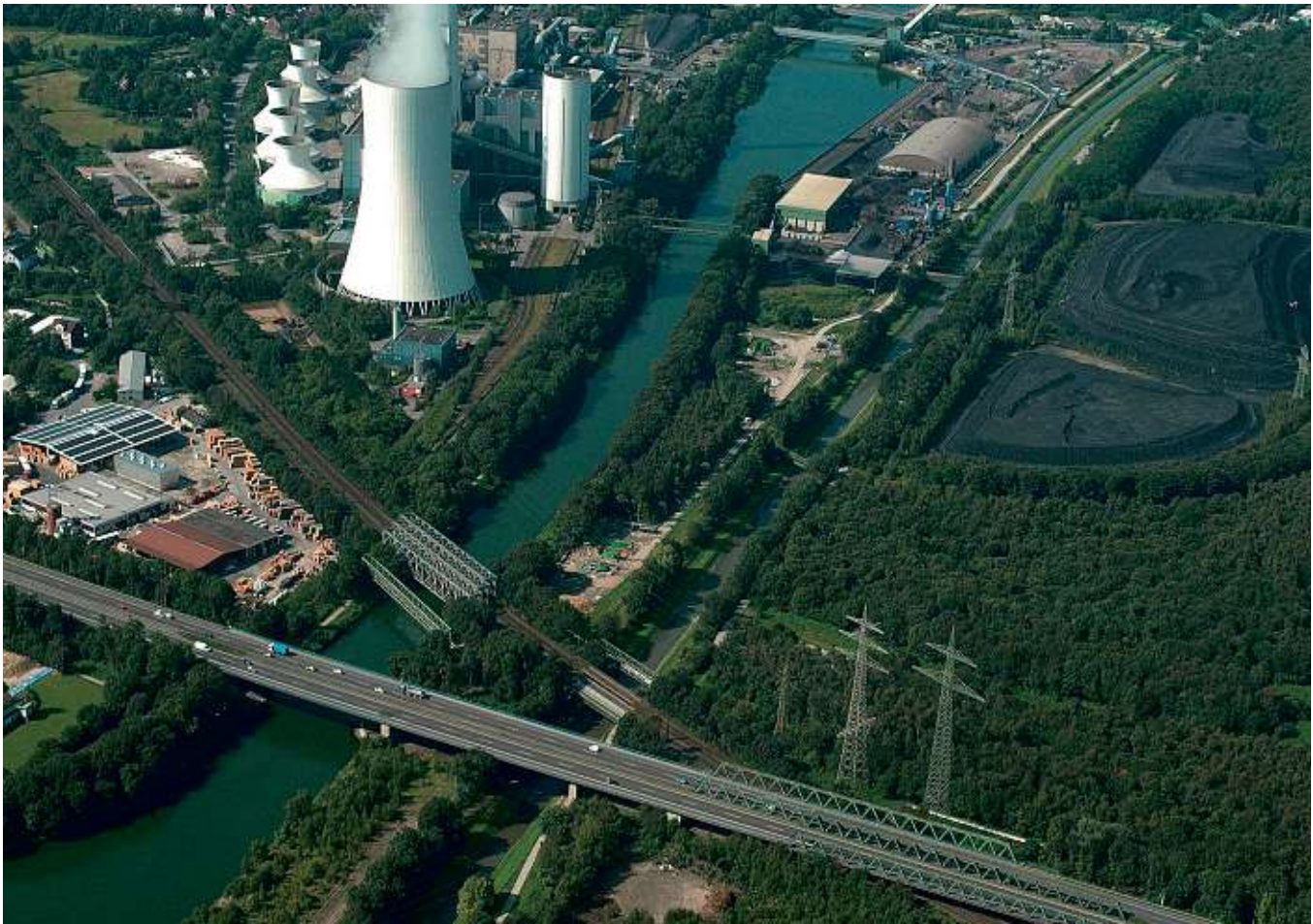
Flächendruck im Rhein-Herne-Kanal Ausbaulos fünf in Herne
