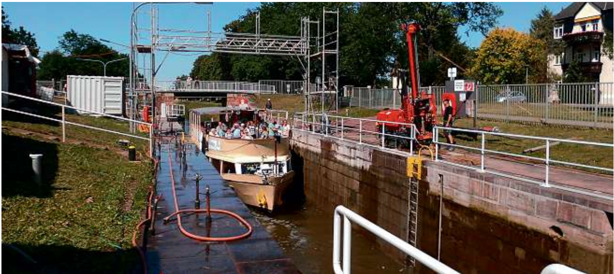
Instandsetzungsarbeiten der Schleuse Meuschau unter Betrieb
