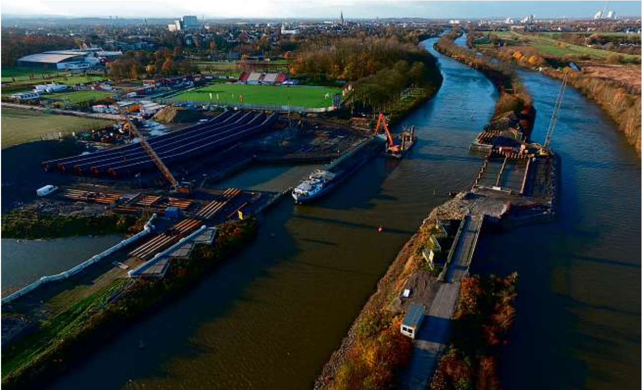
Baustellenfoto November 2017; vorne der bestehende Düker, links die vorgefertigten Rohre des neuen Dükers, rechts die Lippe
