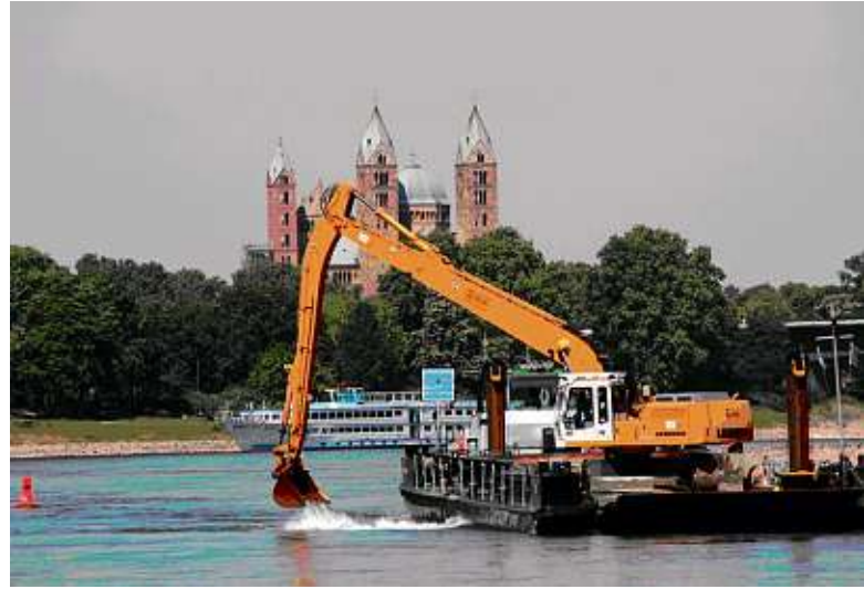
Flussbaggerung bei Speyer
