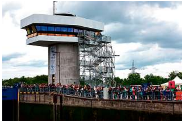
Das Wahrzeichen der Schleuse Iffezheim – der Schleusenturm, Besucher beobachten den Schleusungsvorgang
