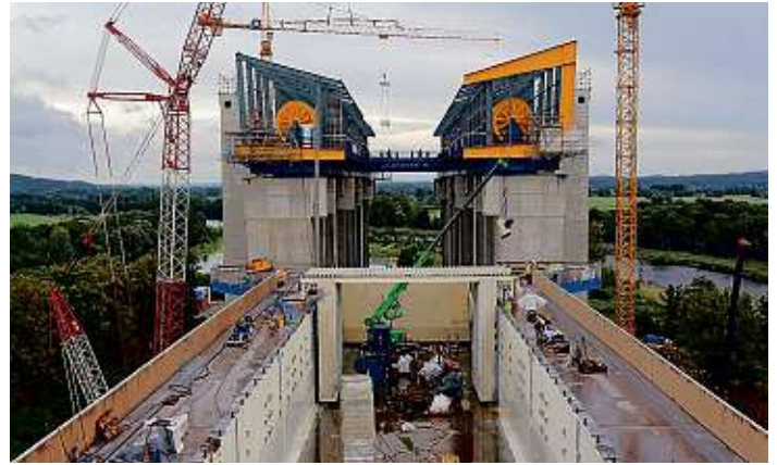
Neubau des neuen Schiffshebwerks Niederfinow
