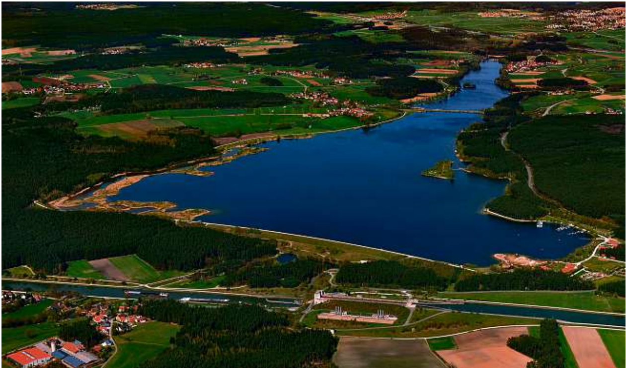
Schleuse Eckersmühlen und Rothsee, Nürnberg, H. Dietz
