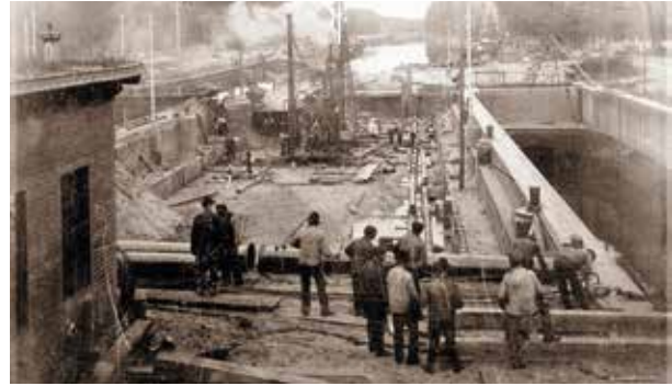
Bau von Nordschleuse und Sparbecken Schleuse Kersdorf, 1904
