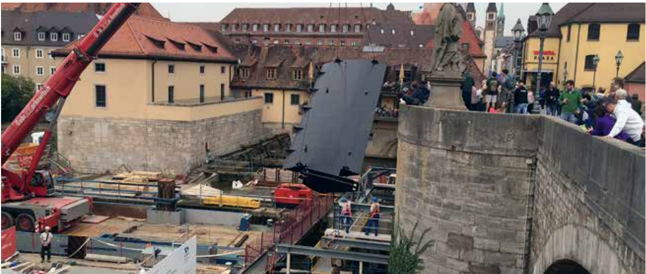
Einheben der neuen Fischbauchklappe
