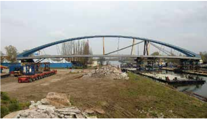
Einschub zweiter Stützponton
