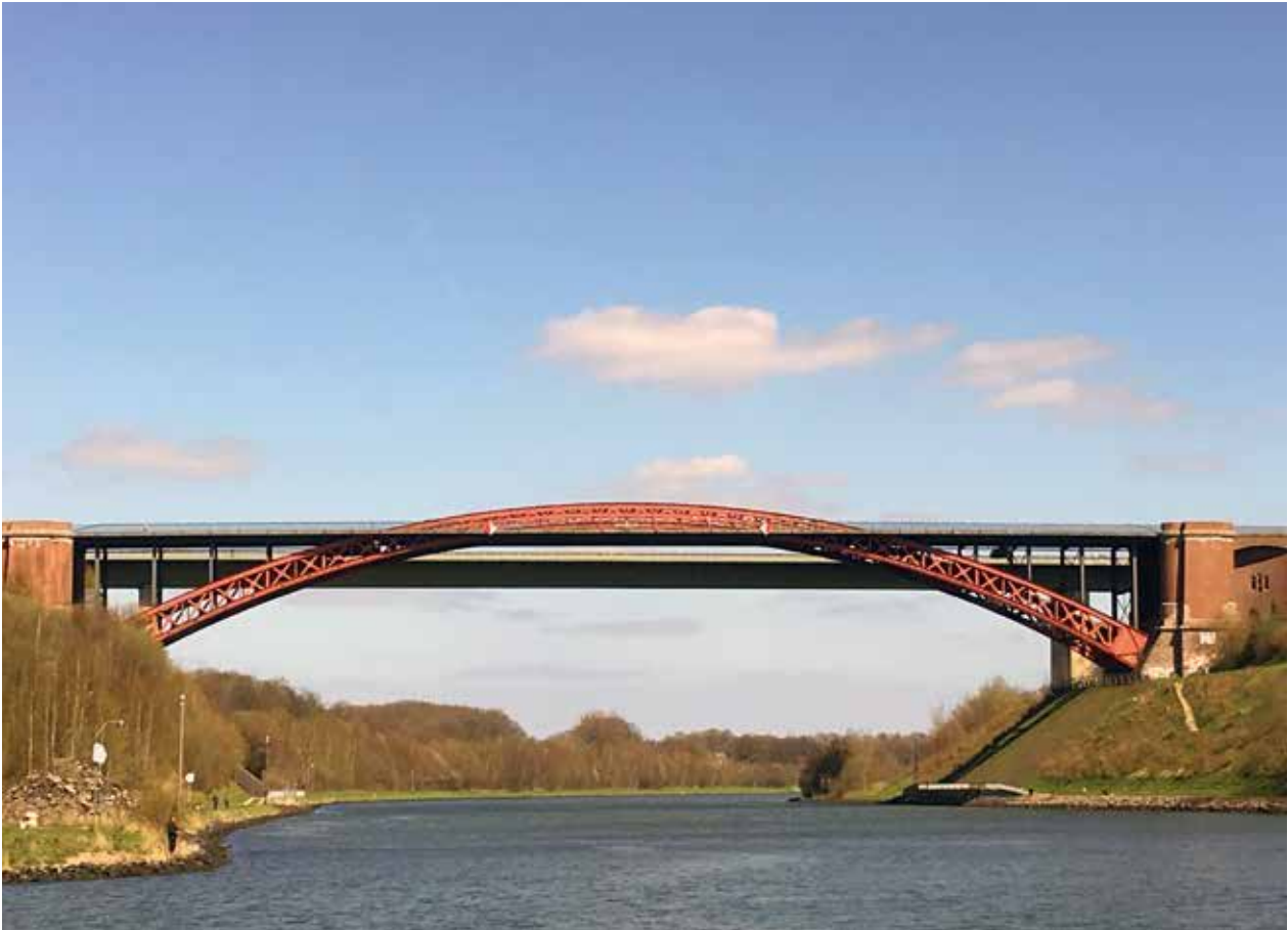
Die alte Levensauer Hochbrücke heute
