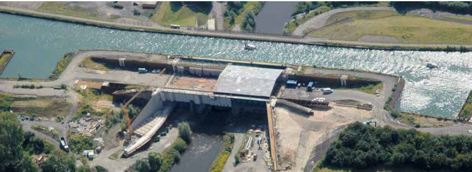
Die Kanalbrücke Lippe, Bau des zweiten Troges (2015)
