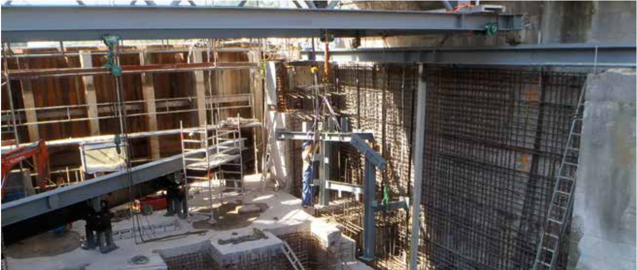
Massivbau Abbruchbereich, Bewehrung Einbauteile, Behelfs-Portalkonstruktion unter dem Brückenbogen in der trockengelegten Wehrgrube
