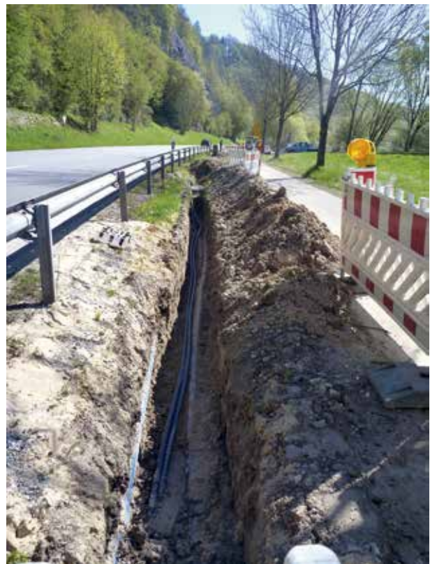
Verlegung des Kabelschutzrohres im offenen Graben
