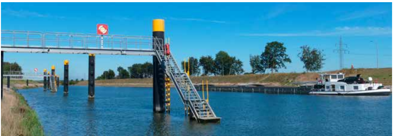
Unterer Vorhafen Warteplatz mit Landgangsteg und Treppe. Die Böschung ist bereits bewachsen.
