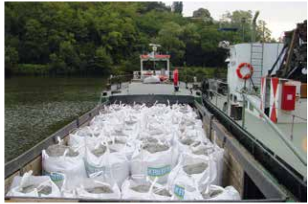
Bigpacks zum Verschließen des Nebengewässers
