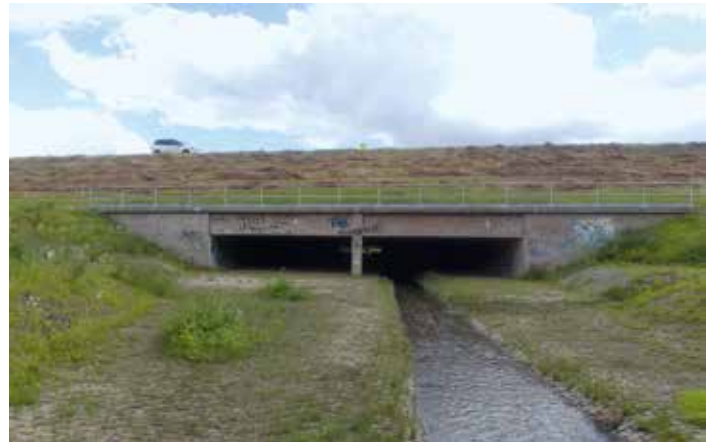
Durchlass Farrnbach, Main-Donau-Kanal
