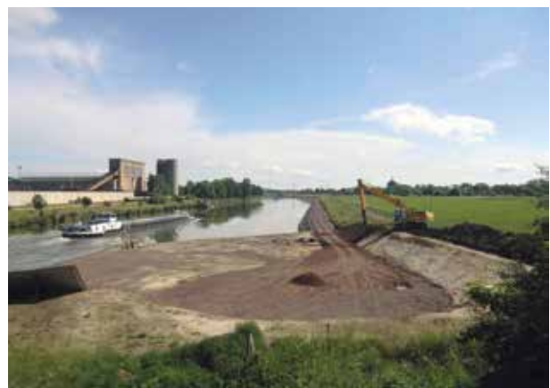
Letzte Arbeiten zur Fertigstellung des kanalbegleitenden Betriebsweges, Blick Richtung Osten, mit Wendestelle
