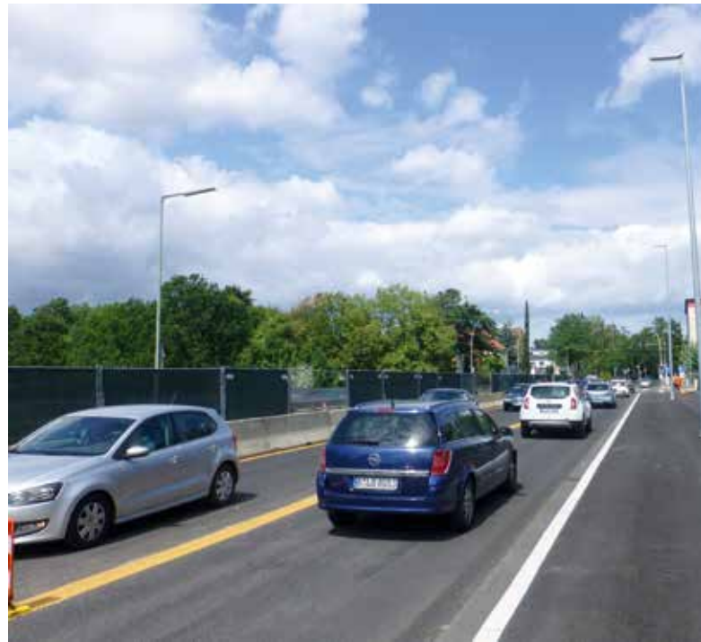
Verkehrsfreigabe für den 1. Bauabschnitt
