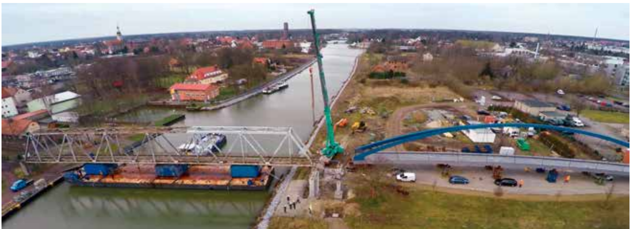
Vorbereitung des Aushubes
