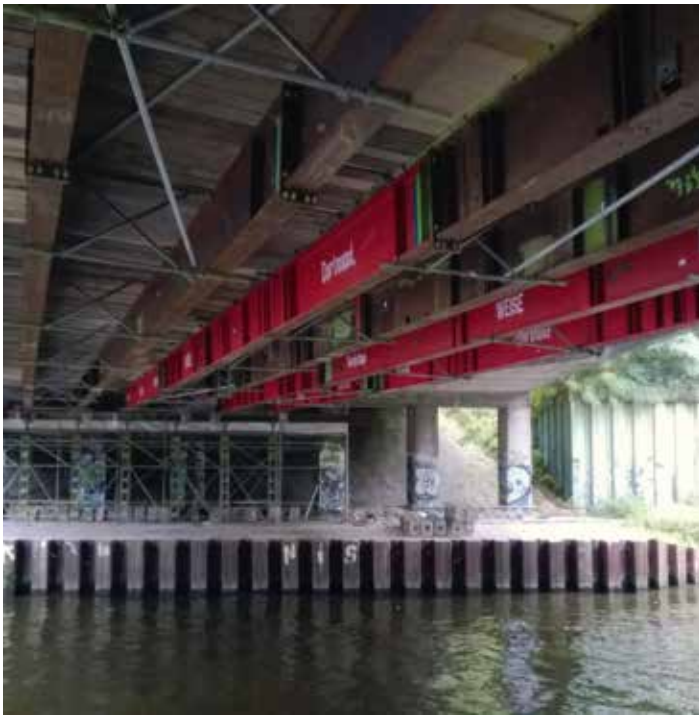
Aufwendige Rüstung unter der Sieversbrücke
