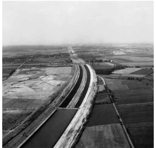
Kanalbett im Bau 1968
