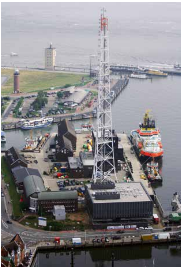
Das Gelände des WSA Cuxhaven mit dem Maritimen Sicherheitszentrum im Vordergrund
