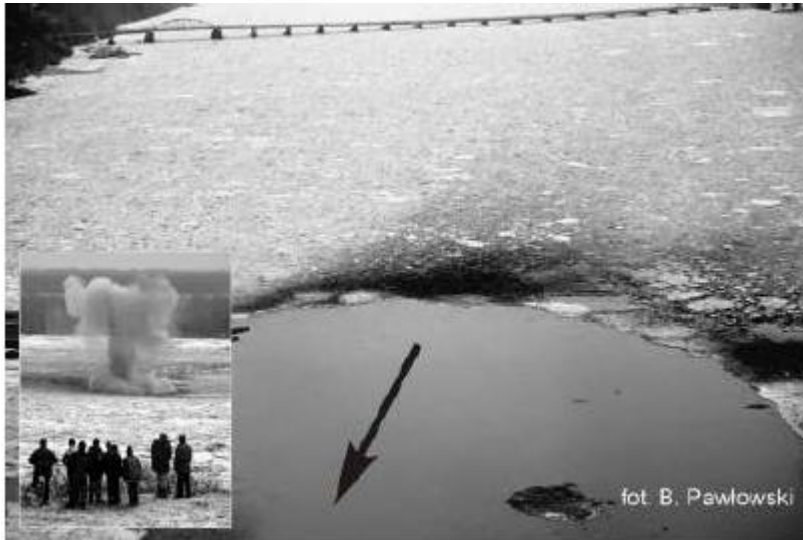
Abbildung 3.4. Versuch, Eisstau im Bereich der Holzbrücke in Wyszogród mit Lasten zu beseitigen. Explosivstoff im Winter 1998; nach der Explosion wurde kein Eisstrom den Fluss hinunter festgestellt (Pfeil zeigt Strömungsrichtung an).
