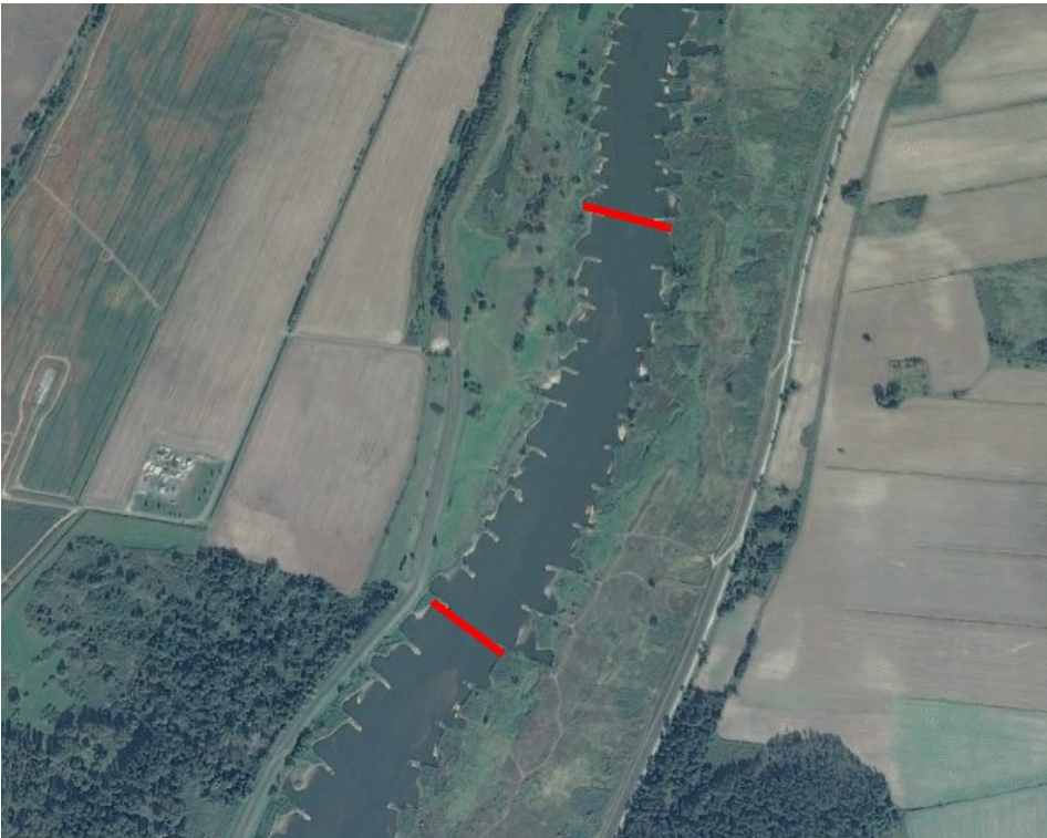
Abbildung 7 Standort des Forschungsbereichs Ługi Górzeckie (km 609+660 - km 610+660)
