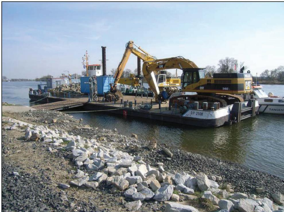
Der Abtransport des Aushubs erfolgt mittels Schuten (motorloser Lastkahn) mit Schubboot.
