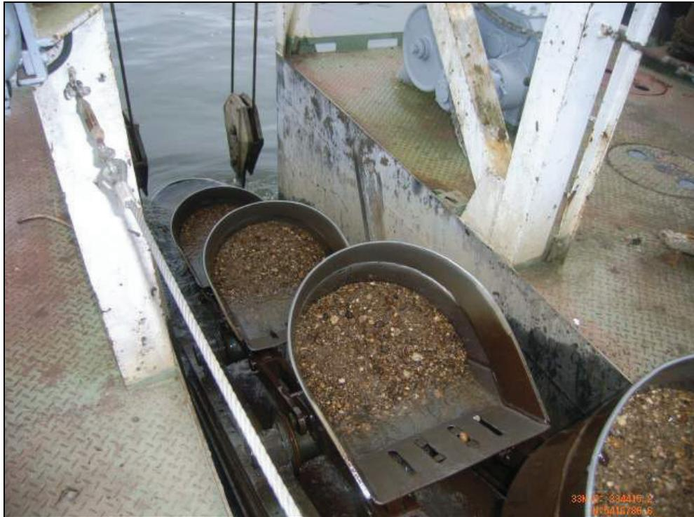
Abbildung 5. Abkippen des Aushubs auf Schute (Beispielfoto)
