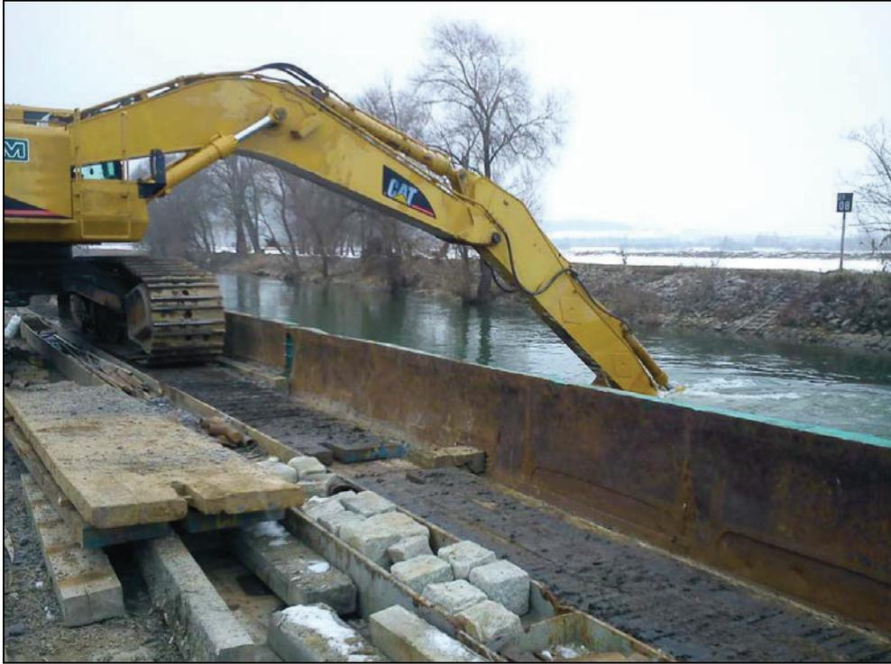
Die sinngemäß gegenteilige Bautätigkeit ist ein Ausheben der Fahrrinne zur Herstellung der benötigten Fahrrententiefe bei der Sohlbaggerung. Zum Einsatz kommen hier Eimerkettenbagger oder Löffelbagger.
