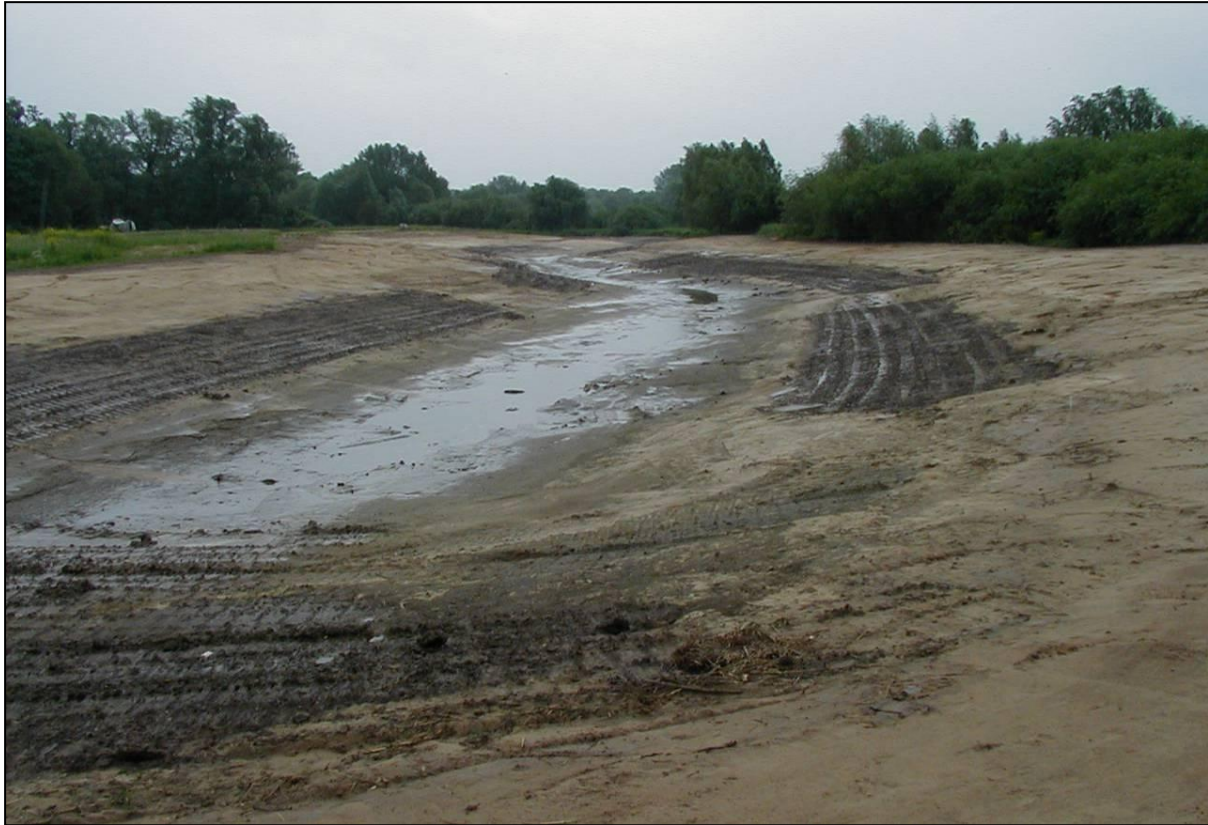
Abbildung 5-1: Priel auf dem Overhaken kurz nach Fertigstellung im Mai 2000.
