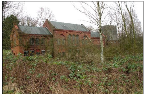
Abbildung 32: Denkmalgeschütztes Gebäude der Hamburger Wasserwerke
