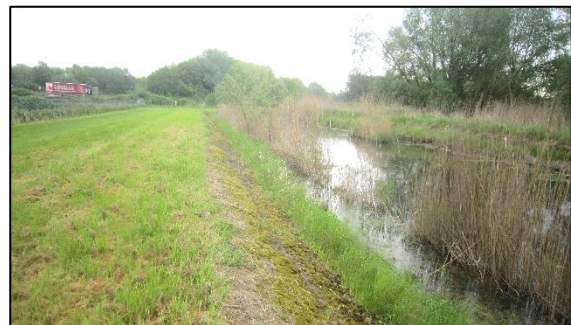
Abbildung 28: Nördlicher Abschnitt des offenen Zuführungskanals
