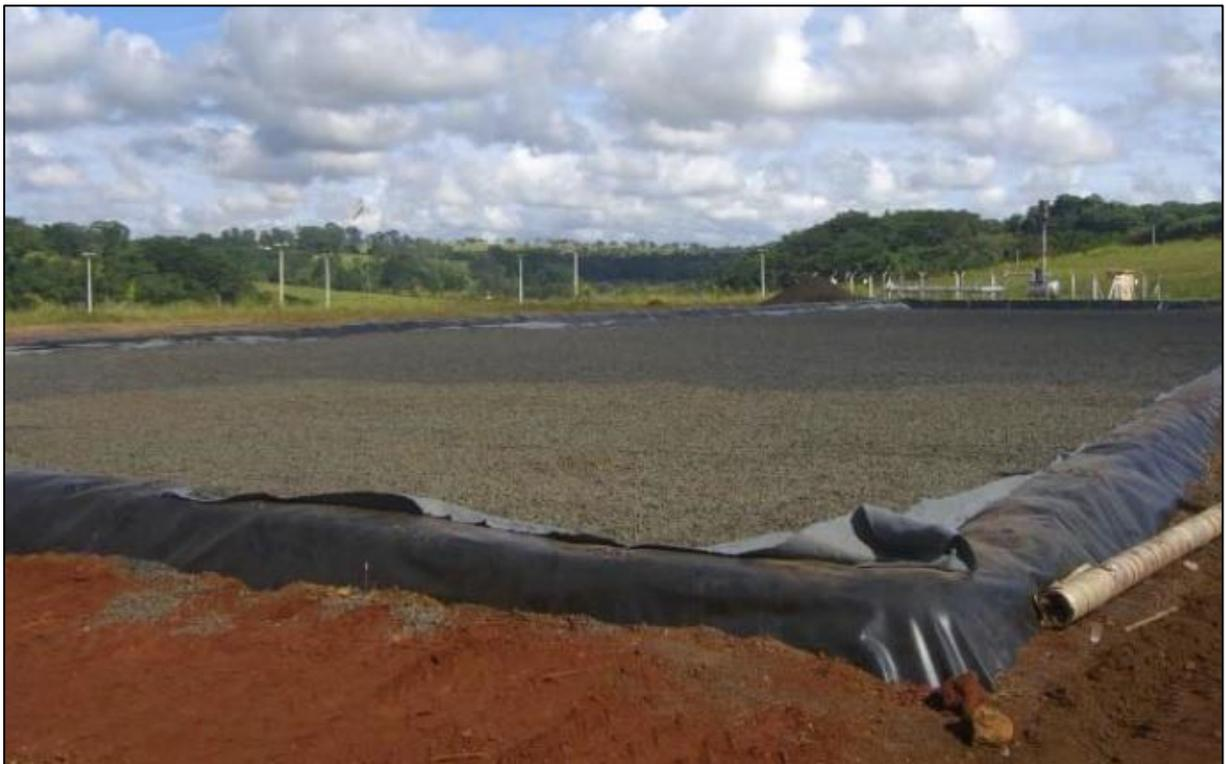
Abb. 3.3: Entwässerungsfeld für den Einsatz von geotextilen Entwässerungsschläuchen [WILKE 2011]
